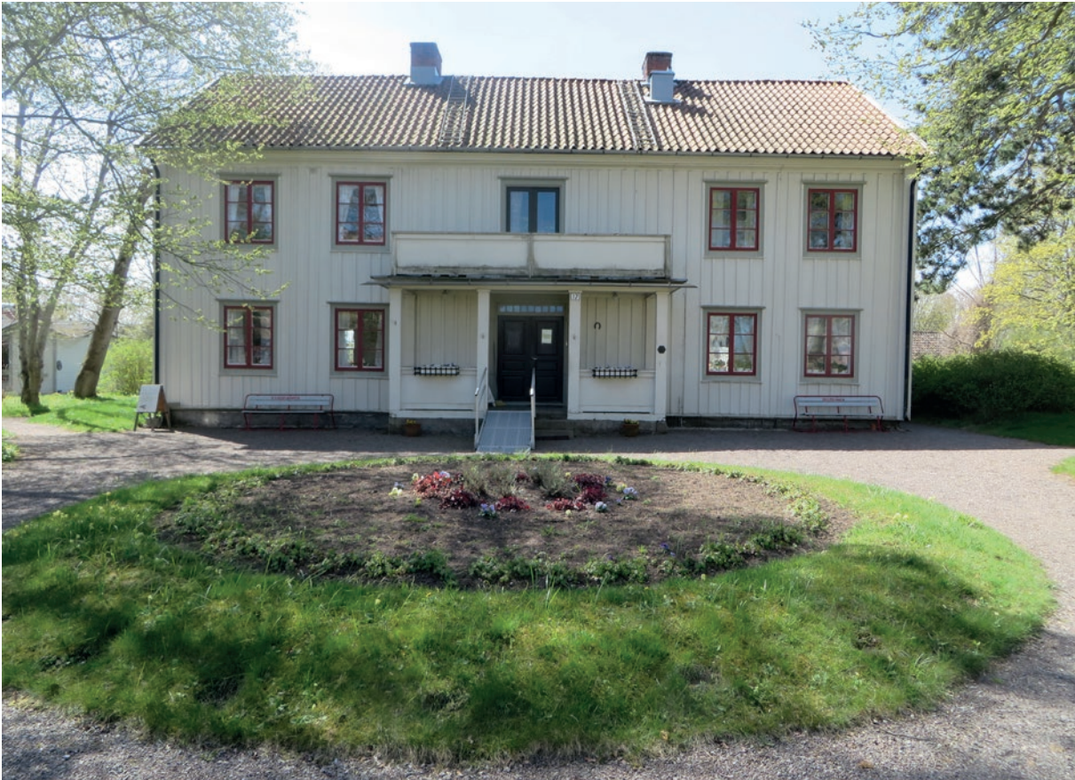
Olssonska gårdens huvudbyggnad fotograferad från norr 2017-05-04, innan arbetena påbörjades.
