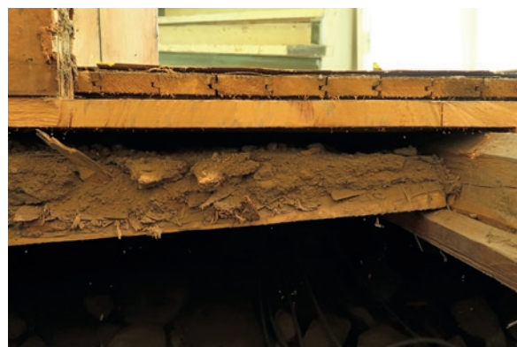
Närbild som visar golvbjälklagets uppbyggnad.
