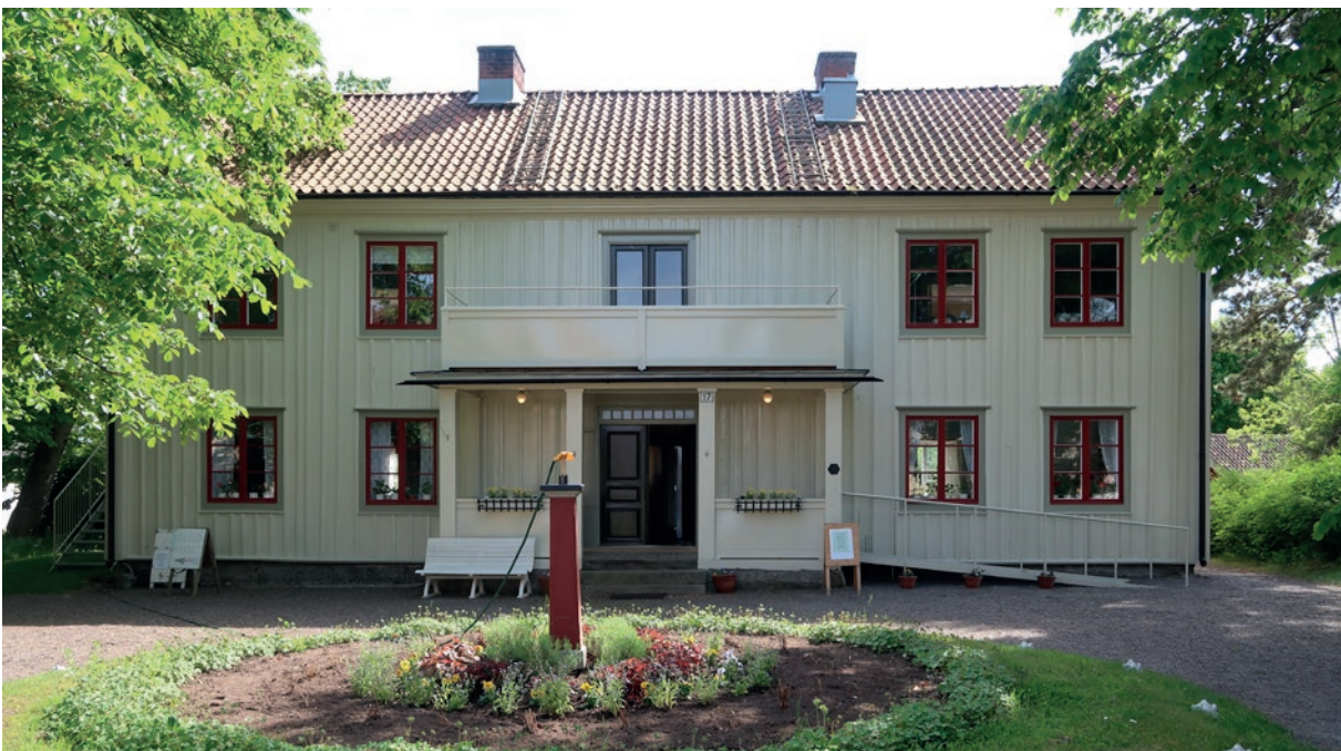
Olssonska gårdens huvudbyggnad fotograferad från norr 2018-05-22, efter avslutade arbeten. En ny ramp har byggts vid verandans högra sida. Den nya utrymningstrappan från andra våningen skymtar vid byggnadens vänstra sida.
