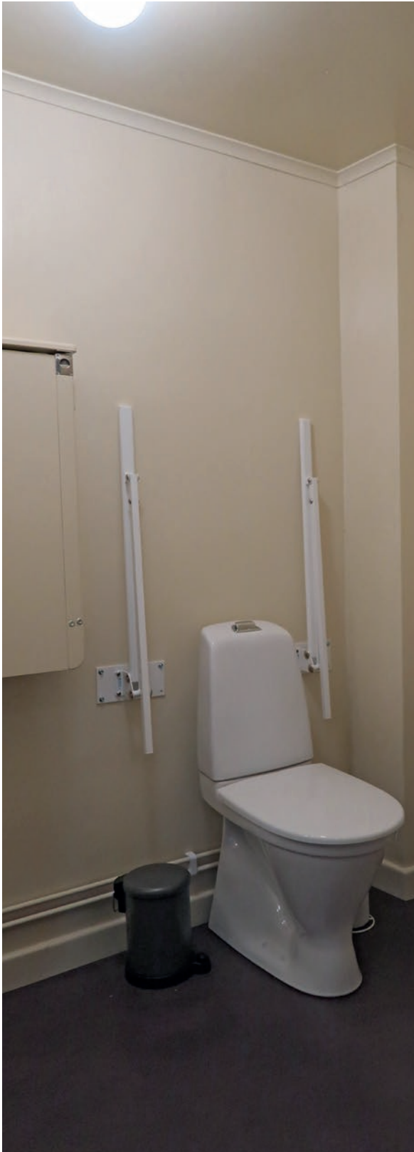
Toaletten har försetts med nedfällbara stöd. Till vänster syns ett nyuppsatt skötbord, fabrikslackerat i samma kulör som väggarna.
