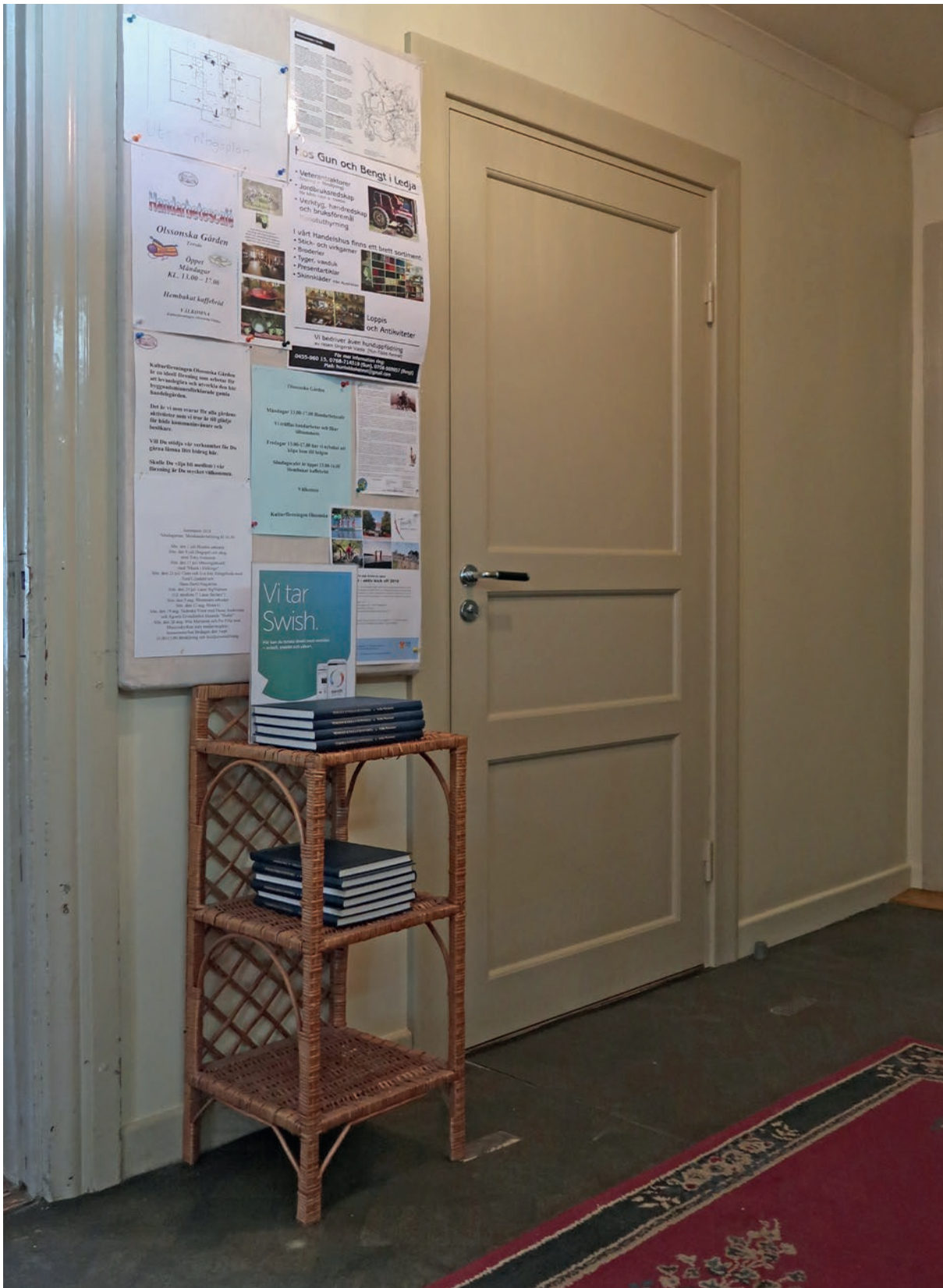
Hallen efter att städutrymmet och den lilla toaletten slagits samman till en större HWC. Den nya dörren är bredare men har i övrigt samma indelning och profilering som de demonterade dörrarna från 1940-talet.
