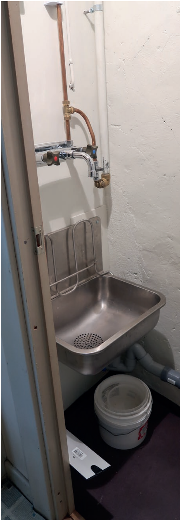
Förrådet efter ombyggnad till städutrymme.
