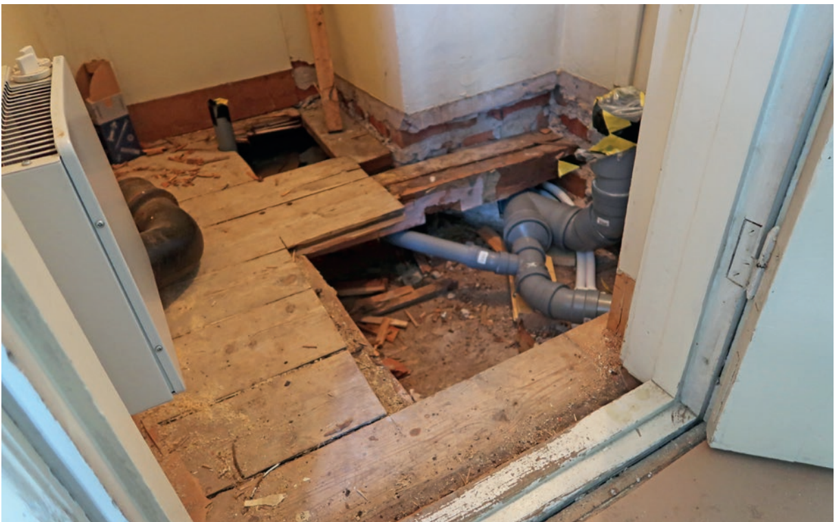
Andra våningens toalett under pågående arbete. Till höger syns nya avloppsrör.
