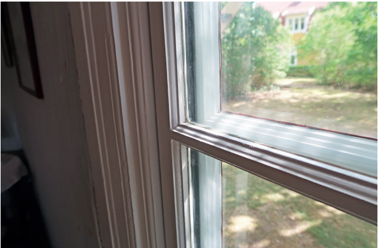
Närbild efter montering av brandklassat glas mellan ytter- och innerbågen.
