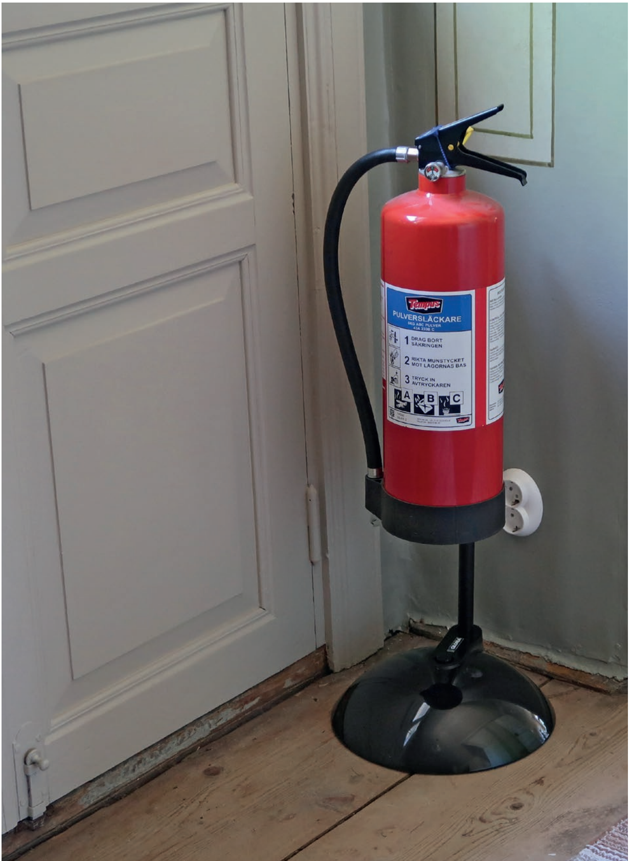
Den nya handbrandsläckaren är placerad på ett löst golvstativ.
