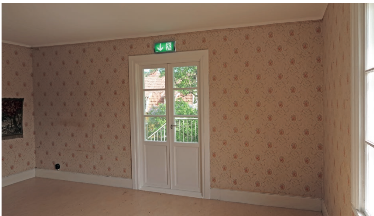
Efter montering av utrymningsdörr.
