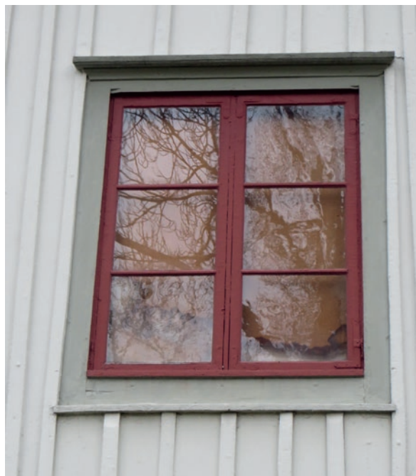
Närbild av det igensatta fönster som senare ersatts av en fönsterdörr.
