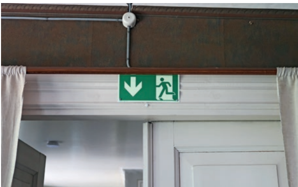
Små efterlysande utrymningsskyltar har monterats över fyra dörröppningar, enligt anvisningar från stf. räddningschef Finn Jensen.
