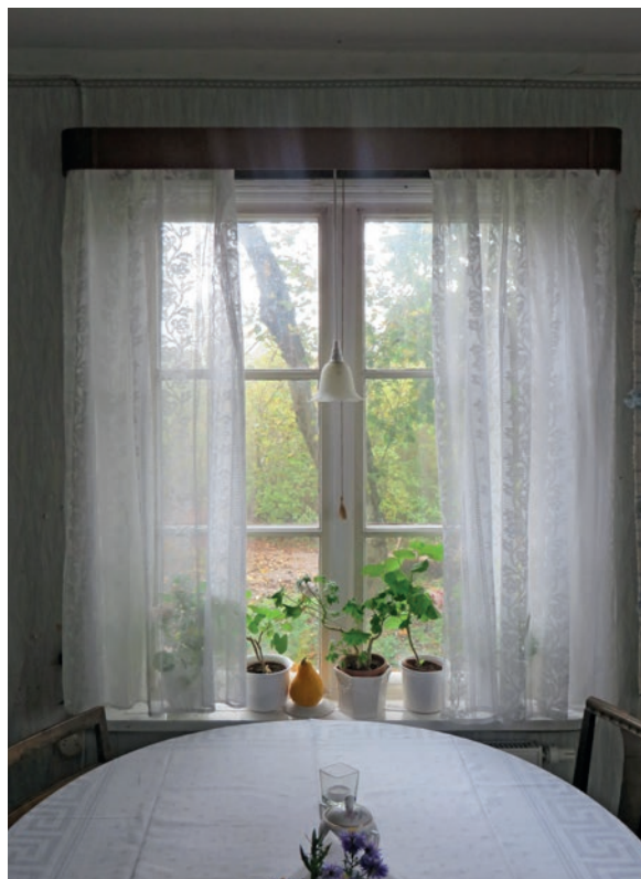
Samma fönster (sett från insidan) före åtgärd.
