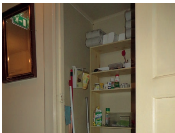
Städutrymmet före ombyggnad. När rummet tillkom på 1940-talet var det inrett som toalett.
