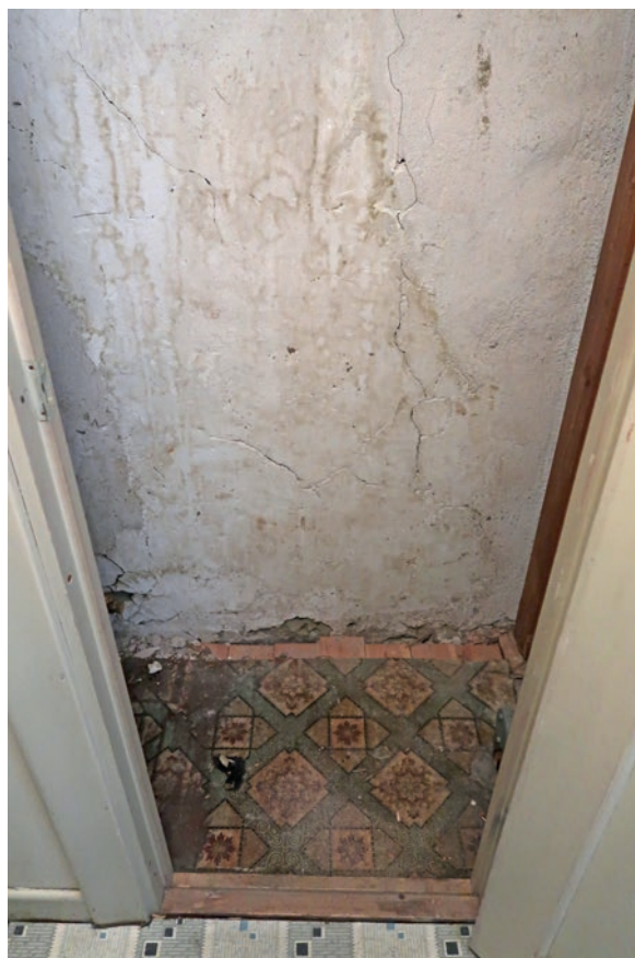
Befintligt förråd före ombyggnad till städutrymme.
