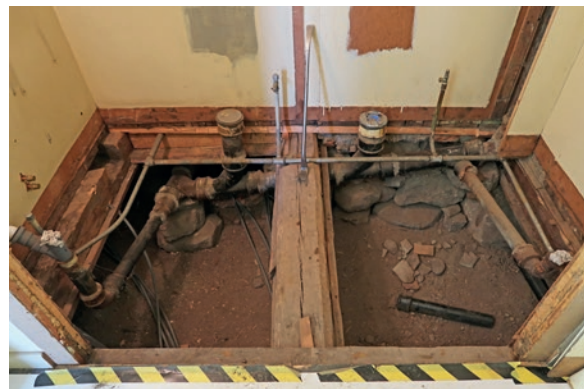
Städutrymmet och toaletten efter rivning av golvbjälklag.
