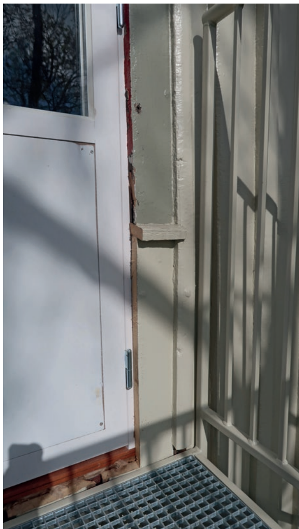
Fönsterdörrens utsida innan den kläddes med panel.
