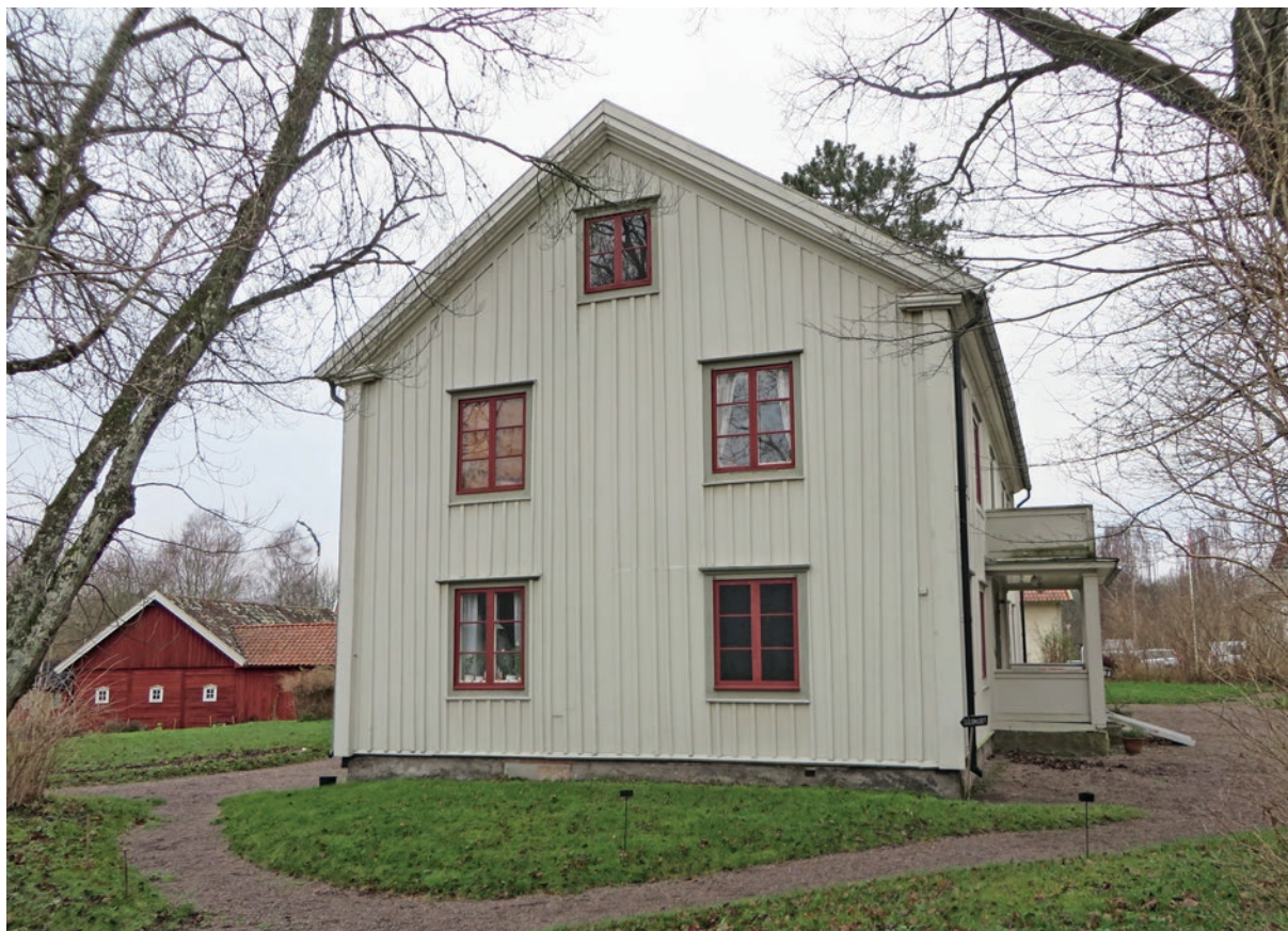
Östra gaveln före montering av utrymningstrappa. Fotografi från 2014.
