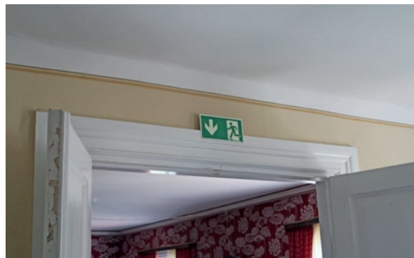
Små efterlysande utrymningsskyltar har monterats över fyra dörröppningar, enligt anvisningar från stf. räddningschef Finn Jensen.
