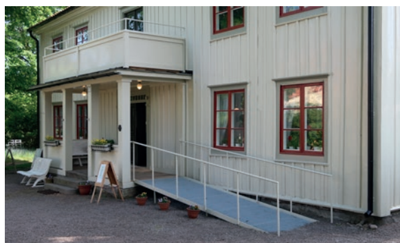
Huvudbyggnaden fotograferad från nordväst 2018-05-22, efter avslutade arbeten. Den befintliga fronten vid förstubrons västra sida har tagits bort för att ge plats åt en ny ramp.
