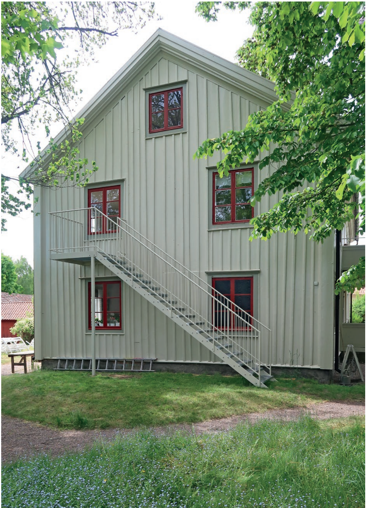
Östra gaveln efter montering av utrymningstrappa.
